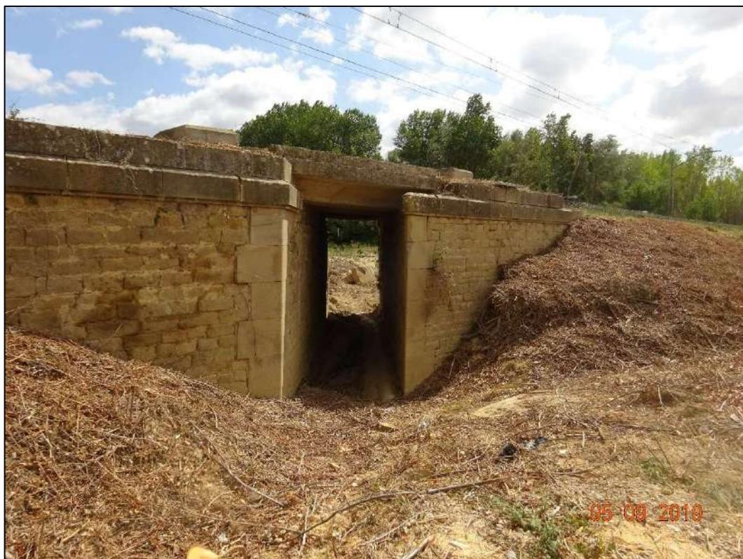
**Ilustración 48.** Infraestructuras longitudinales, aguas arriba del casco urbano de Olite, que no tuvieron la suficiente capacidad hidráulica para dejar fluir la riada que se originó el 8 de julio de 2019. El puente de las vías del tren supuso un obstáculo que favoreció el desbordamiento – en ambos márgenes - en este punto.
