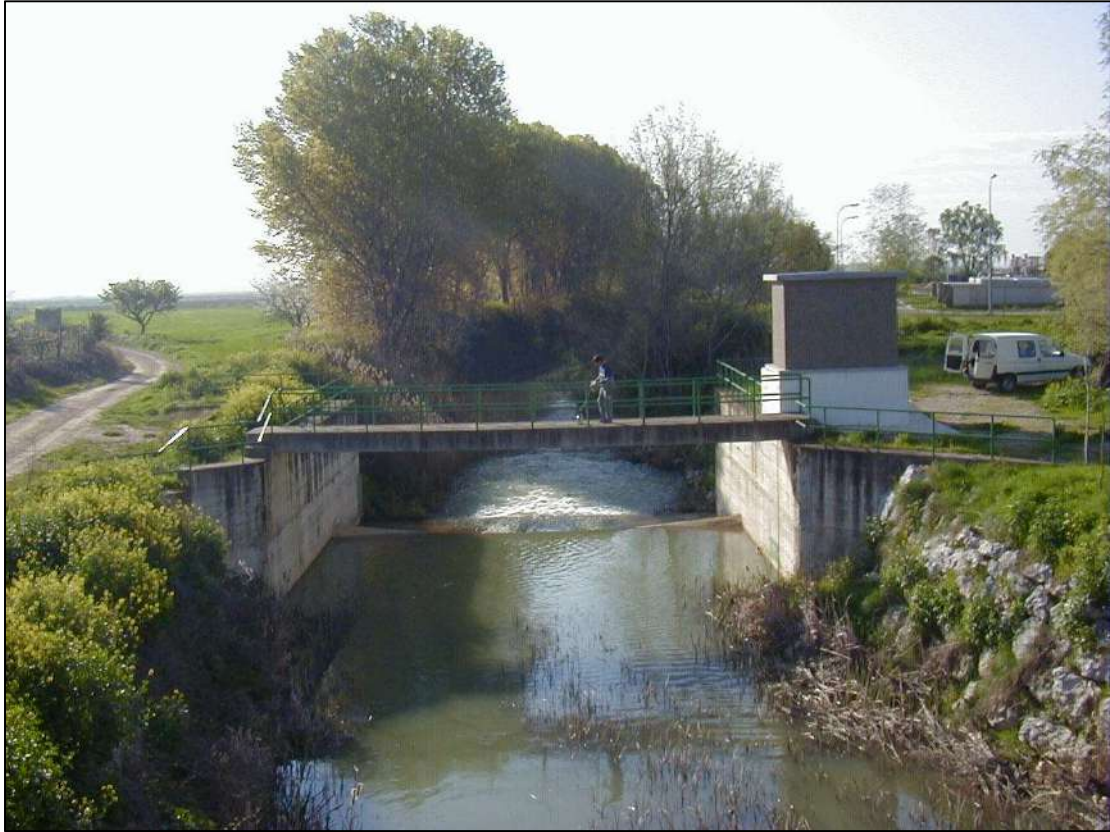
Ilustración 12. Vista de la estación de aforo del río Cidacos/Zidakos en Olite, propiedad del Gobierno de Navarra. Código AN 540. Fotografía de GAN-NIK.
