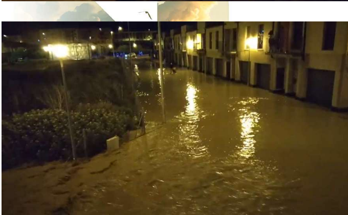
Ilustración 26. Avance de la inundación por la calle Graciano, ya en la zona sur del casco urbano de Olite. En la foto superior se observa como el agua desbordada circuló por la zona de las vías del tren Pamplona-Madrid, bajo el cruce de la carretera NA-5300 hacia San Martín de Unx por la calle Graciano. La foto inferior muestra como la inundación alcanzaba ya también las casas de la calle Tempranillo. Fuente: https://www.youtube.com/watch?v=wepUG5w43IY
