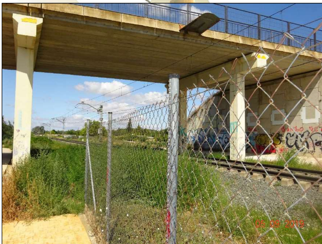
Ilustración 28. Vista del puente de la carretera NA-5300 con dirección a San Martín de Unx, sobre las vías del ferrocarril, que siguen un marcado trazado en dirección norte-sur, muy similar al del cauce del río Cidacos.
