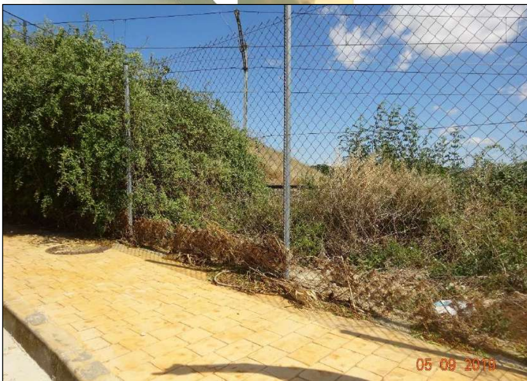
Ilustración 57. La riada circuló por debajo del puente de la carretera NA-5300.
