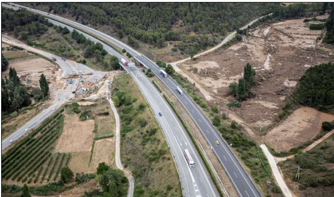
Ilustración 27. Imagen aérea de la zona de salida del barranco del río Sansoain, que tras cruzar canalizado bajo la autopista Ap-15, aporta sus aguas al río Cidacos aguas arriba de Tafalla.
