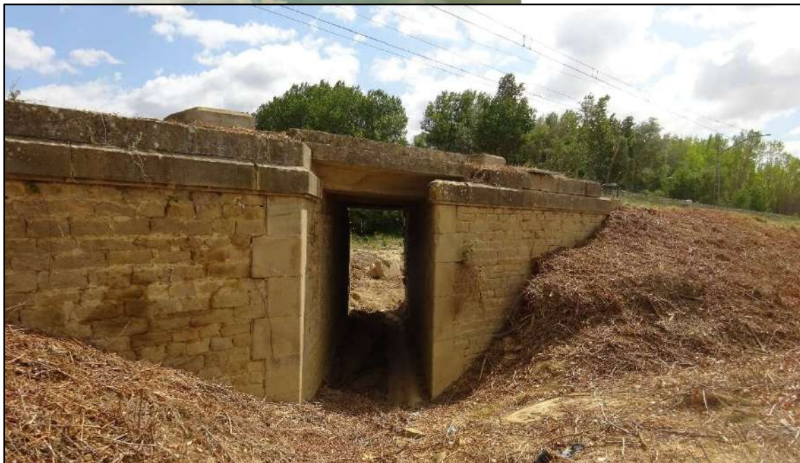
Ilustración 32. Punto de paso bajo, por el que circuló el agua desbordada en esta zona de la margen izquierda del río en la zona de los puentes [1] y Puente de Hierro [2]. Imagen tomada en septiembre de 2019, con la zona ya limpia tras la riada.
