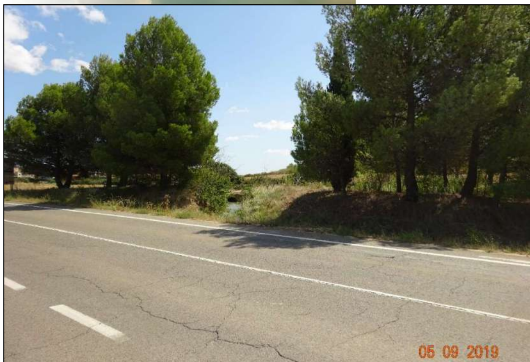
Ilustración 59. Zona de la salida de la Autopista AP-15, en la que pueden formarse balsas en tormentas de intensidad elevada. Este punto no ha sido incluido como tal en el plan, al no estar relacionado con los desbordamientos del río Cidacos, si bien se recomienda su vigilancia y control en caso de tormentas fuertes en la zona del casco urbano.
