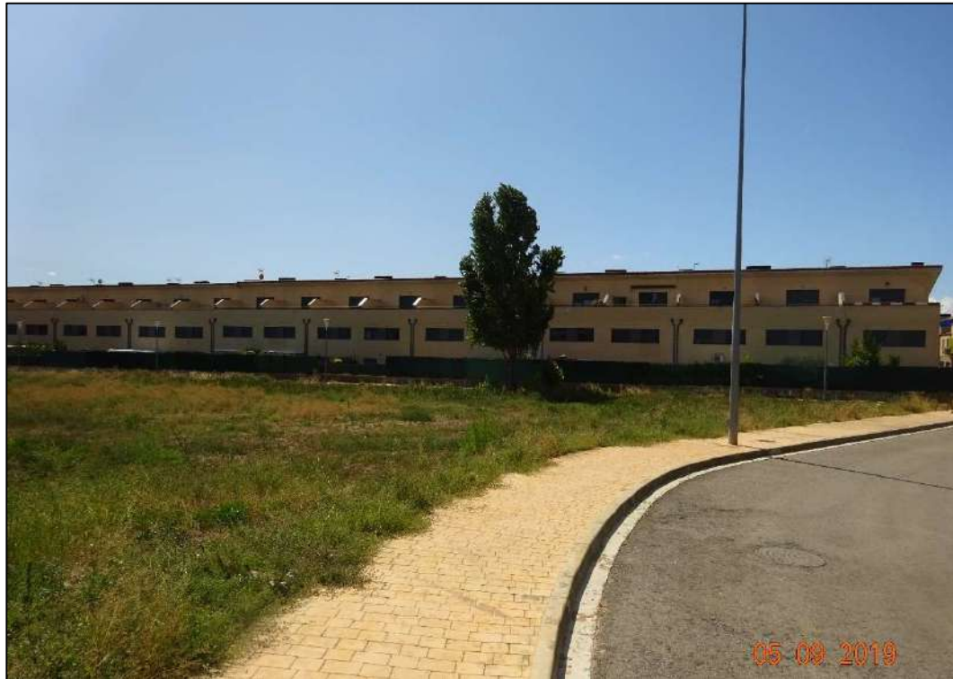
Ilustración 58. La inundación se extendió por la margen derecha del río y de las vías del tren hasta la parte sur del casco urbano, donde la inundación fue muy importante en las calles Graciano y Tempranillo.
