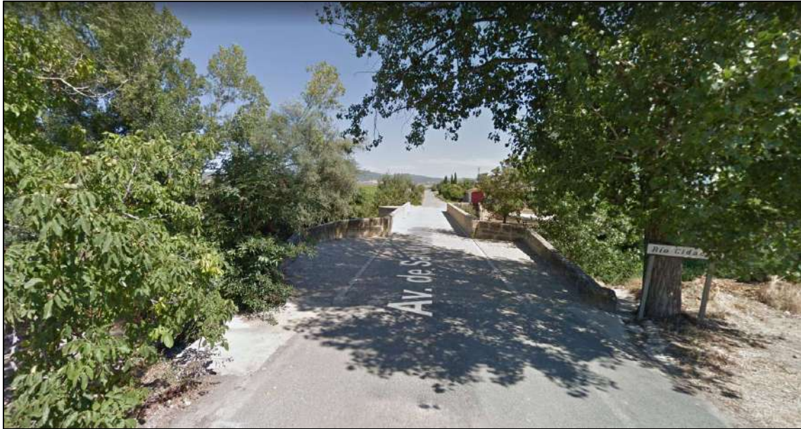
Ilustración 33. Puente sobre el río en la Avenida San Martín de Unx. Imagen obtenida de Google Maps.
