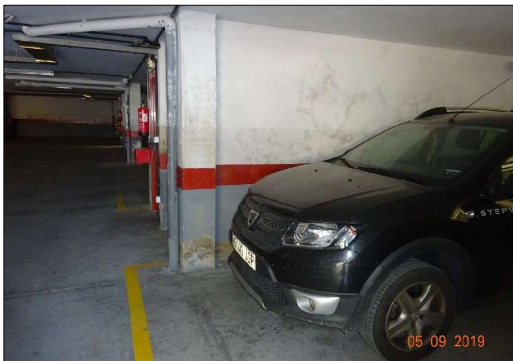
Ilustración 54. La inundación también afectó gravemente a los vehículos aparcados en los garajes de la zona de las calles Merindad de Ultrapuertos y adyacentes. En estos garajes el calado supero el metro y medio de profundidad.
